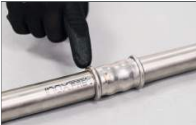
Controllo della pressatura / Checking the press connection
